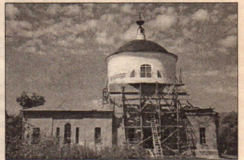
Успенская церковь с. Закубежье. Современный вид
